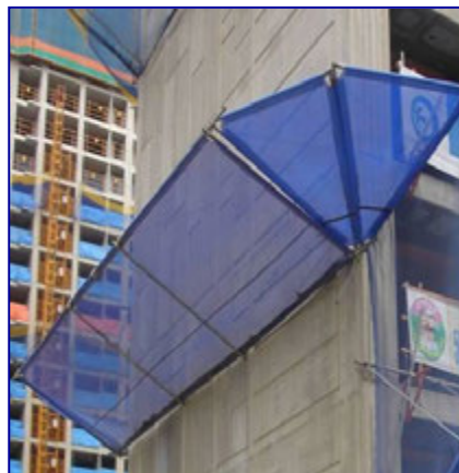
ตัวอย่างแสดงการป้องกันการกระเด็นหรือตกหล่นของวัสดุ
