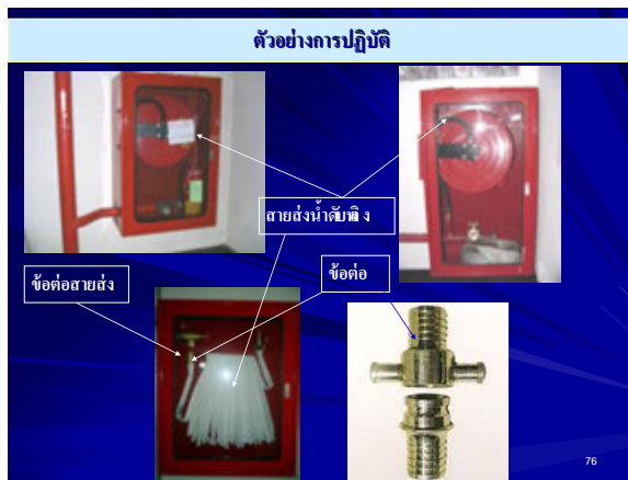
ตัวอย่างแสดงระบบน้ำดับเพลิงและอุปกรณ์ประกอบ
