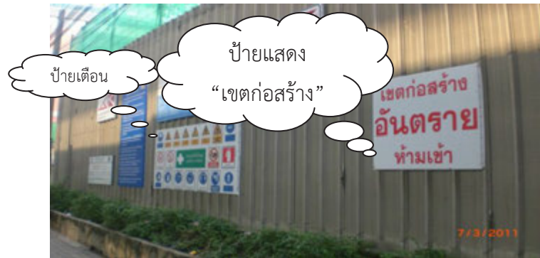
ตัวอย่างแสดงเขตก่อสร้างและป้ายเตือน
