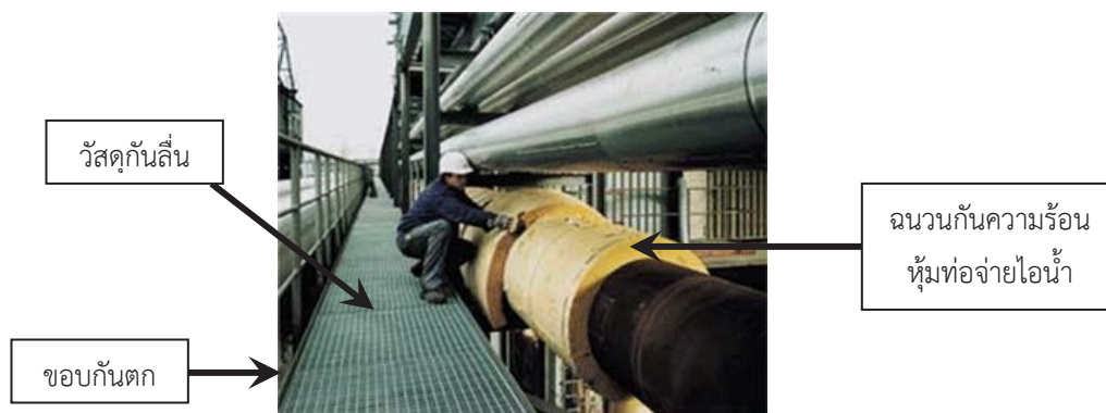
ตัวอย่างแสดงขอบกันตก วัสดุกันลื่น และฉนวนกันความร้อน
