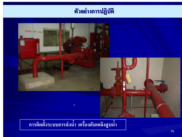
ตัวอย่างแสดงระบบน้ำดับเพลิงและอุปกรณ์ประกอบ
