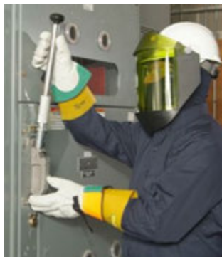
ตัวอย่างแสดงชุดคุ้มครองความปลอดภัยจากไฟฟ้า
