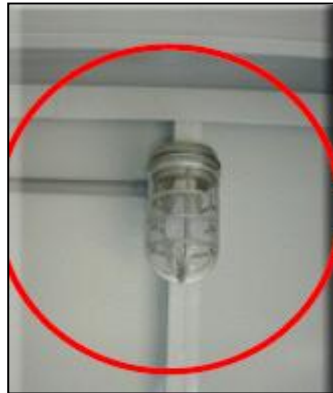
รูปที่ 8 ระบบแสงสว่างในอาคารเก็บสารเคมี
